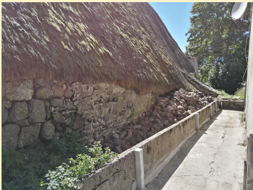
Le mur nord... avant / après, un changement spectaculaire....
