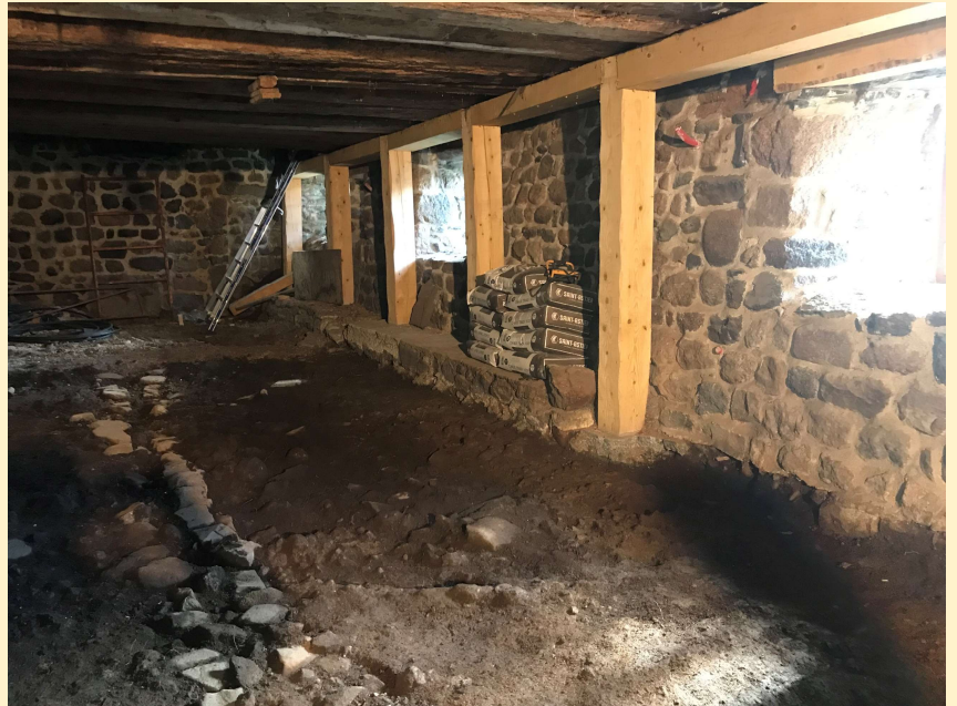
A gauche , après dépose de la dalle, découverte de la canalisation d'origine
