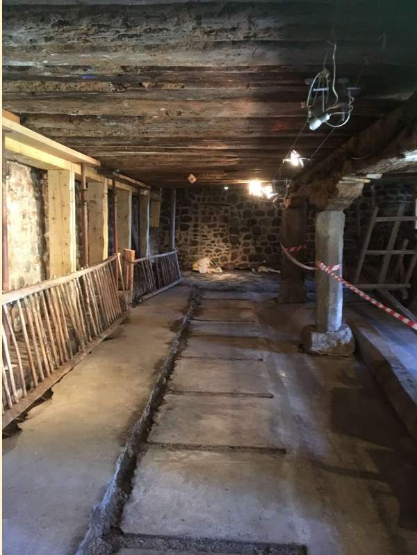
A gauche : l'étable avant travaux
