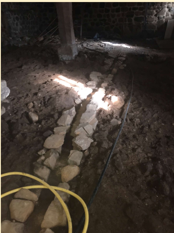
A gauche , après dépose de la dalle, découverte de la canalisation d'origine
