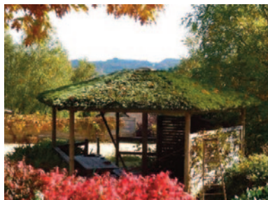
Gloriette réalisé par Henri M. Stagiaire 2015, avec le concours des Pépinières du Velay
