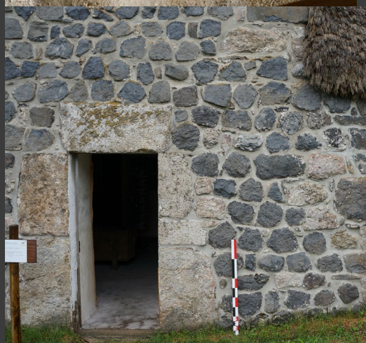
Rejointoyage des murs au ciment
