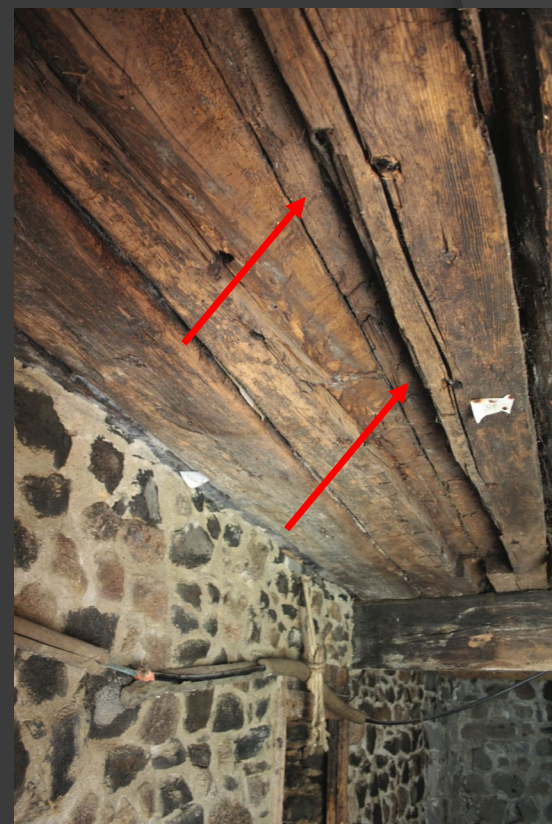
Rainure dans le plafond de l'étable correspondant à une cloison disparue
