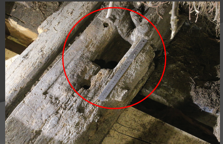
Mortaise sur une pièce de plancher en remploi
