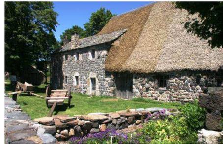
Après la rénovation intégrale de la toiture en genêt, les travaux d'étanchéité sur la façade Ouest, le changement d'une partie des portes et fenêtres, les travaux vont reprendre avec l'arrivée des beaux jours.
